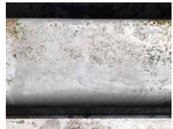
【作業後】 40分後、ウエスを剥がした部分のみサビが除去されました。
